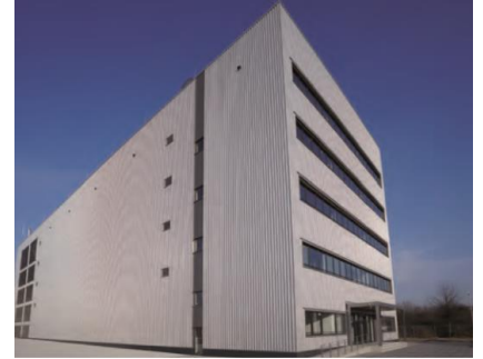
BT Data Center Frankfurt-Sossenheim
